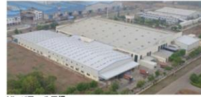
IJL パワール工場
